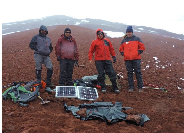
Installation finalisée de l'une des stations (Photo : S. Hidalgo – IG-EPN).
